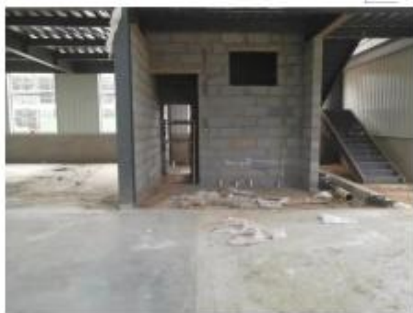
拟租赁厂房内部（附楼）
