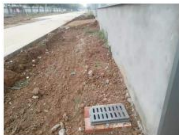
拟租赁厂房铺设的雨水管网
