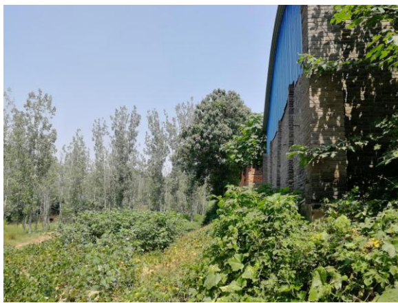
厂区西侧空地
