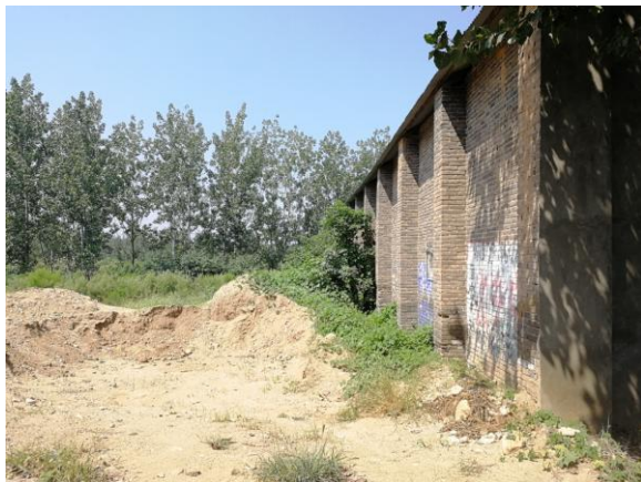
厂区南侧空地
