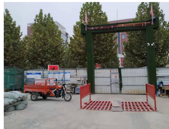
车辆冲洗设施
