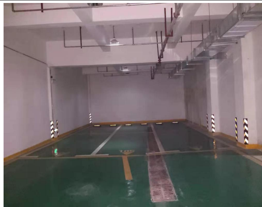
能源站处选址现状
