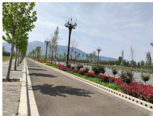
项目西侧道路
