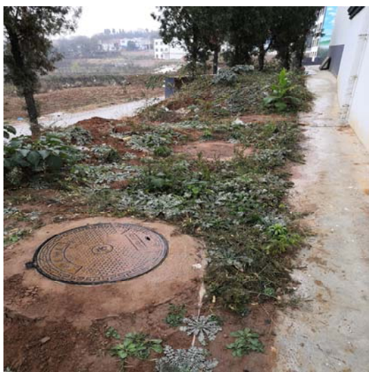
项目租赁厂区东侧及现有化粪池位置
