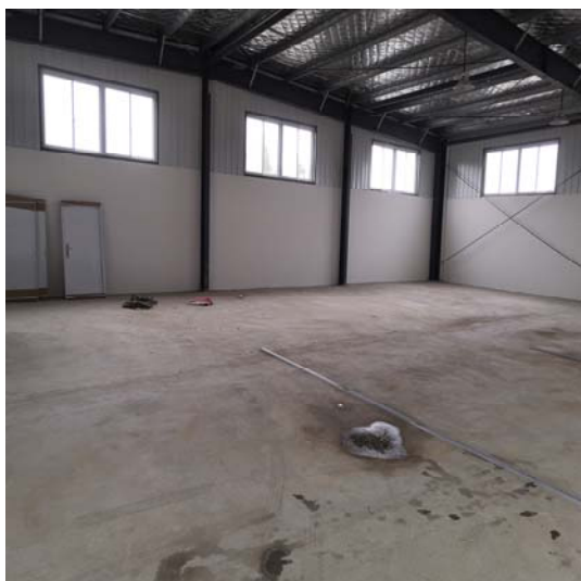
项目生产车间现状
