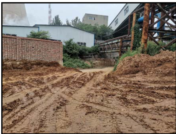
项目所在厂区大门
