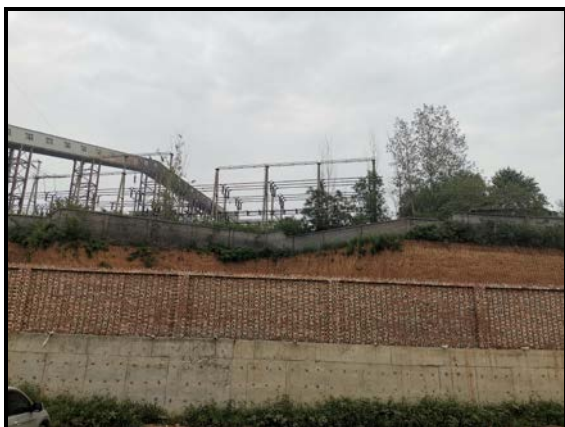
项目所在厂区东侧 河南升扬硅业科技发展有限公司
