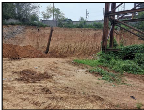
项目所在厂区现状
