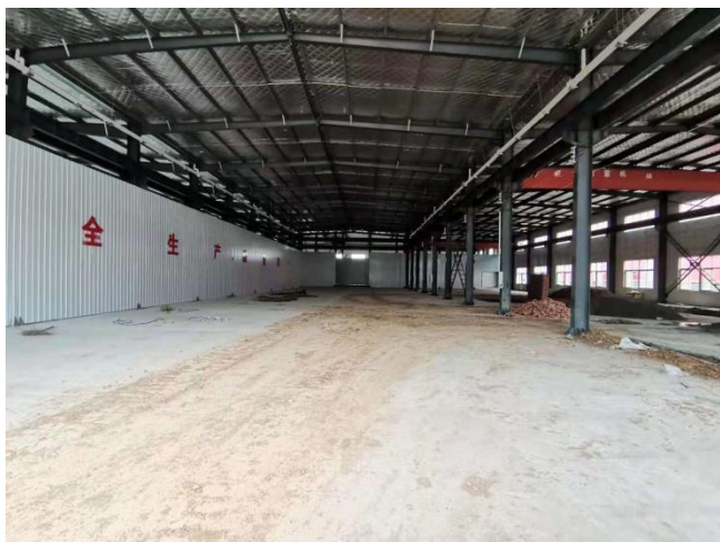
车间现状照片
