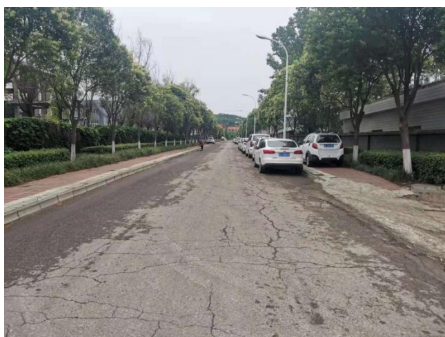
厂区西侧建业路
