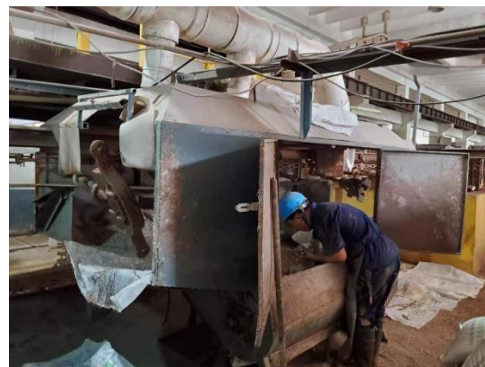
本项目车间制壳线现状
