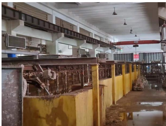
本项目车间制壳线现状
