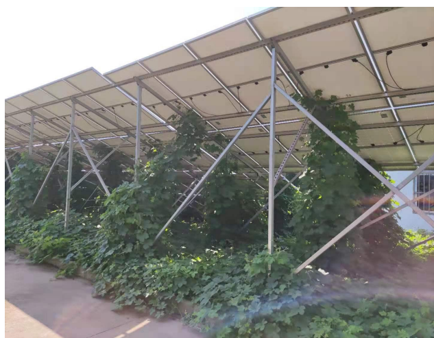
厌氧池位置现状
