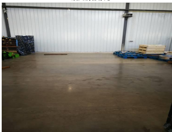
拟改扩建工程区域现状
