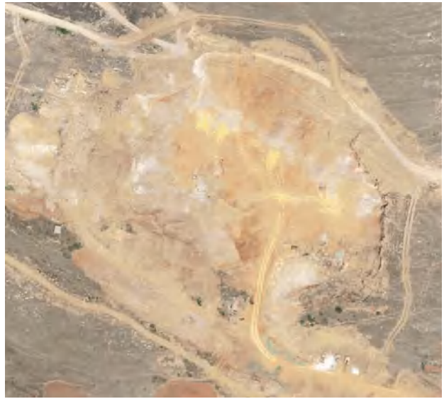
2#露天采坑现状
