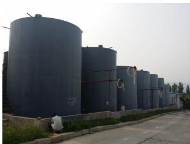
现有工程液体硅酸钠储罐
