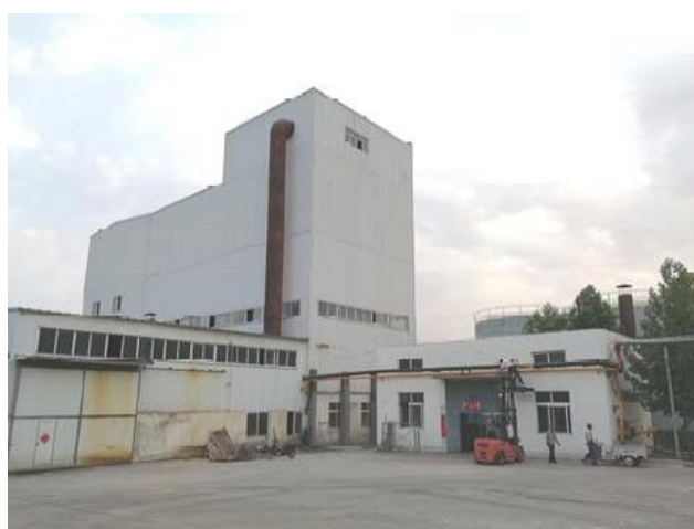
现有工程硅酸钠喷雾干燥车间
