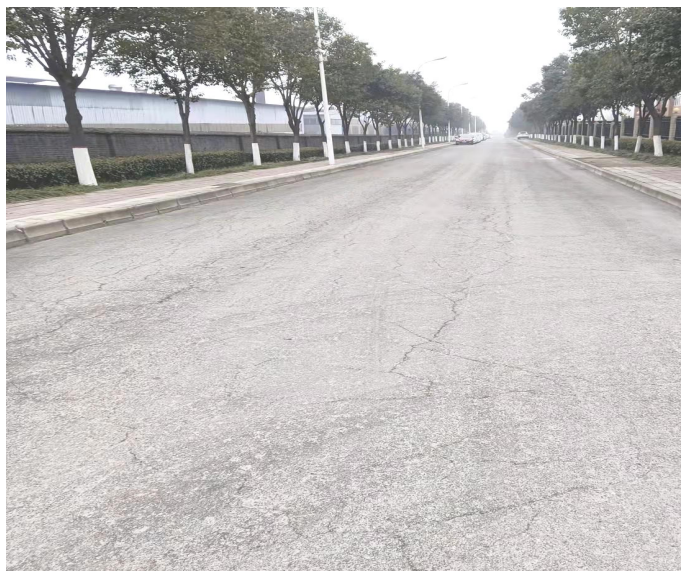
厂区门口道路
