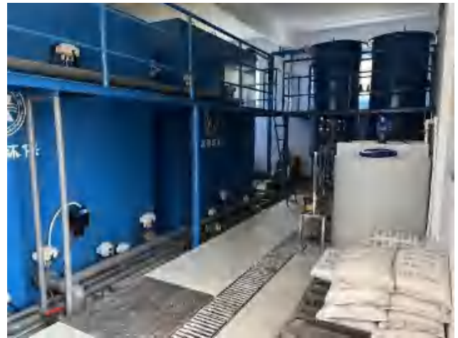
现有污水处理站
