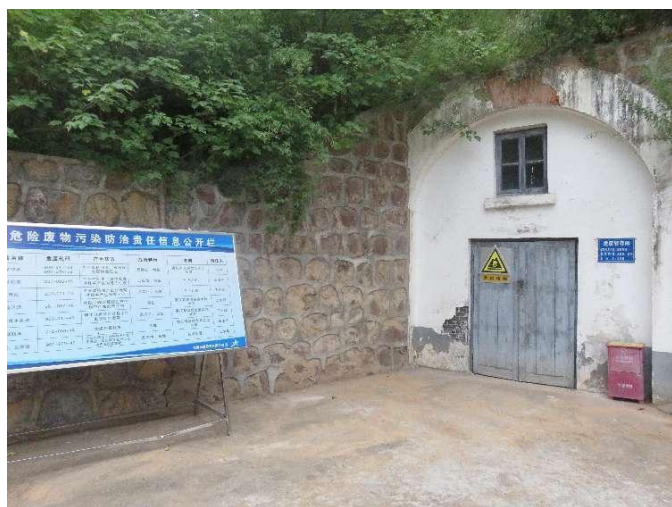
现有危废暂存间
