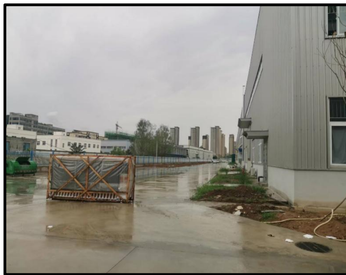
厂房南侧道路
