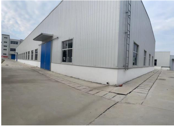
本项目生产车间
