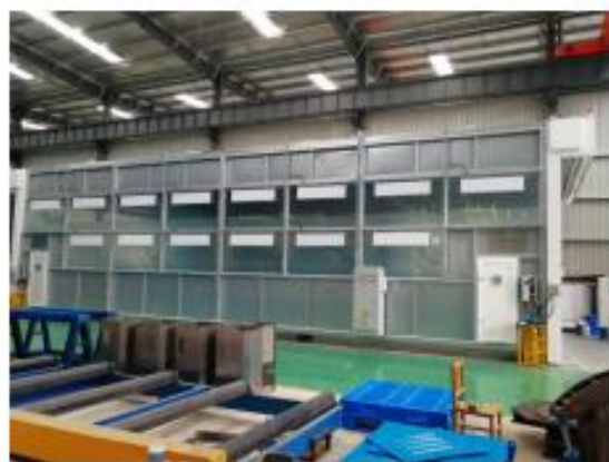
依托现有工程封闭喷漆房
