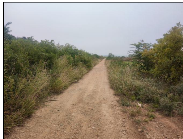
改建、新建施工道路现状
