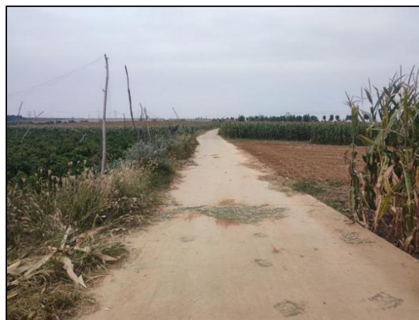
改建、新建施工道路现状
