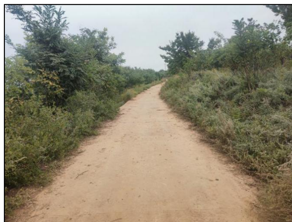
改建、新建施工道路现状
