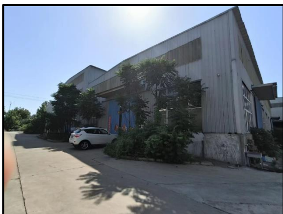
洛阳罡浩机械工程有限公司厂房
