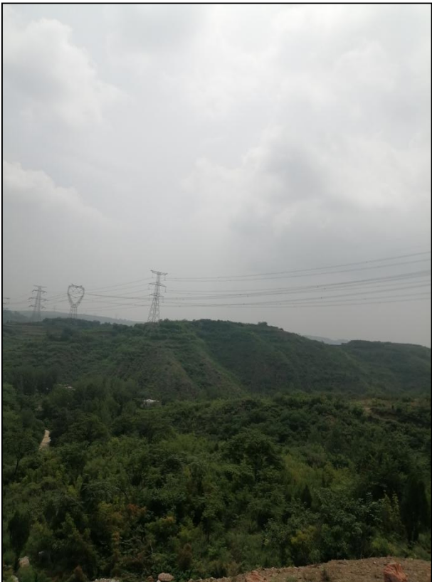
厂区东侧深沟
