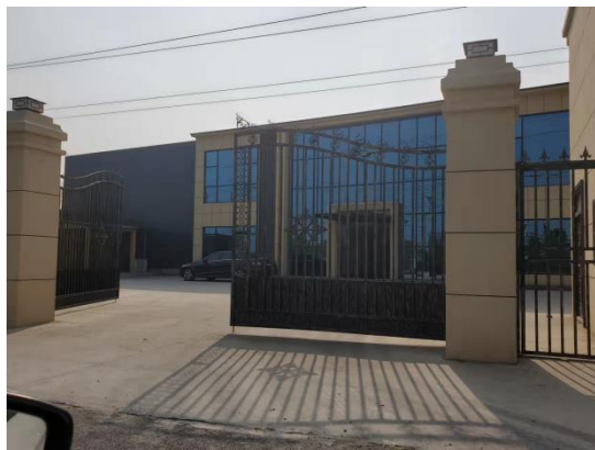
本项目厂区大门
