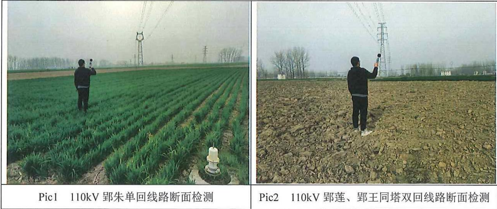
图 2 现场检测照片
