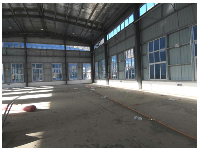
项目仓库现状
