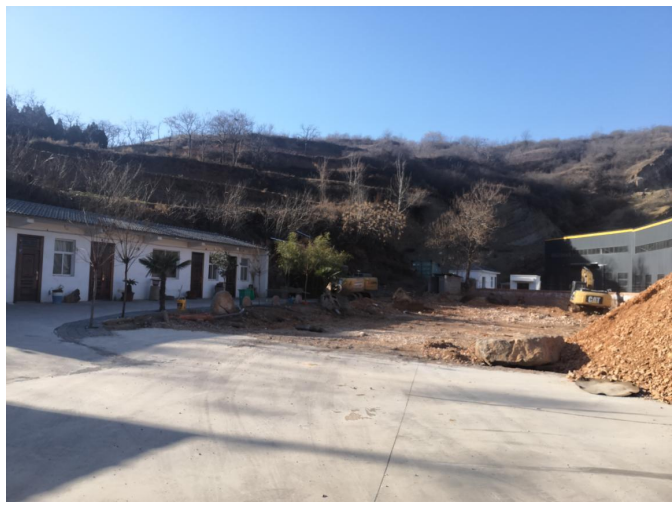
项目南侧闲置厂区
