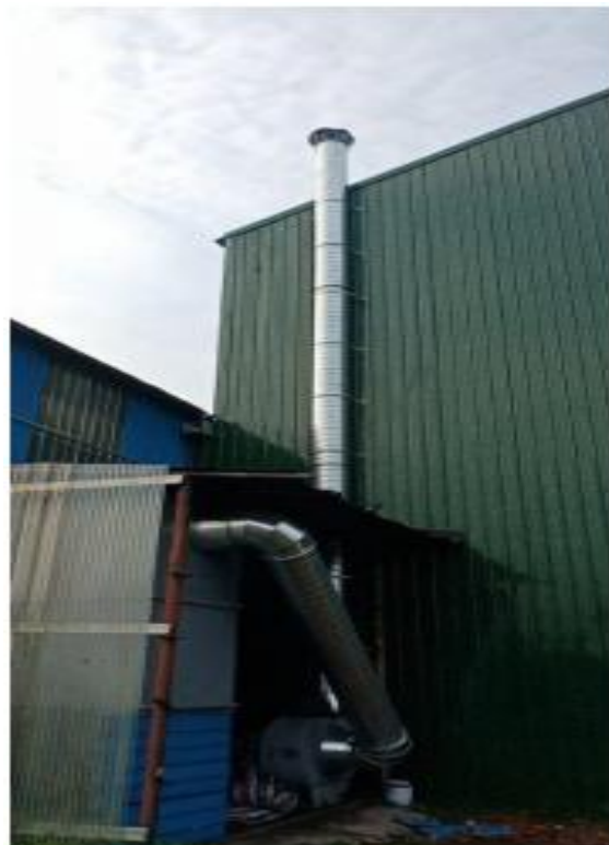
覆膜袋式除尘器+排气筒
