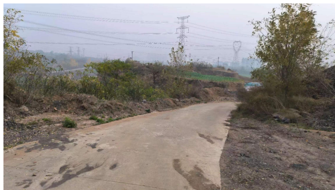
车间南侧道路
