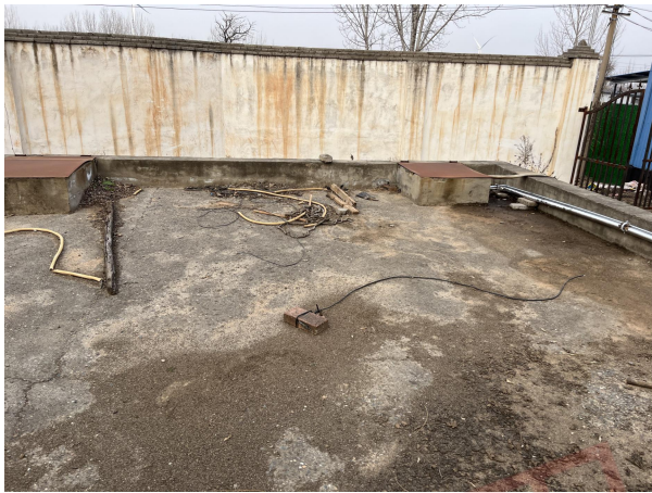
项目西侧的蓄水池
