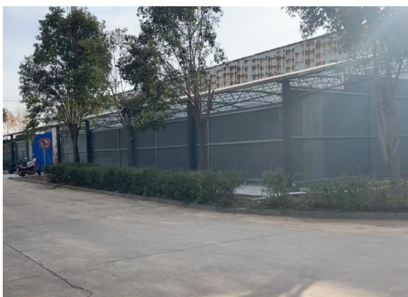
项目所在车间外部情况
