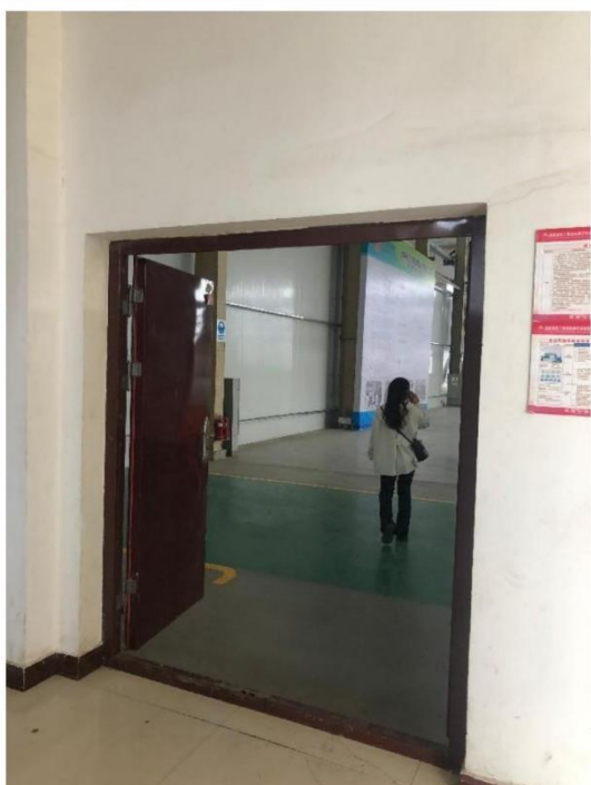
工程师踏勘现场照片
