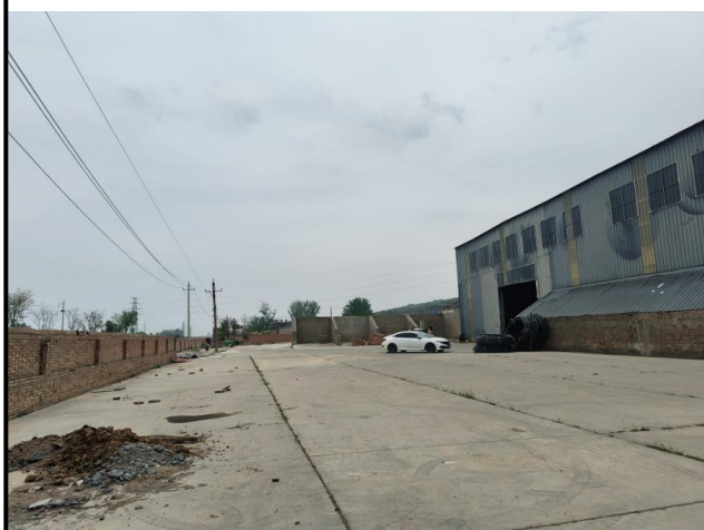
车间北侧厂区道路
