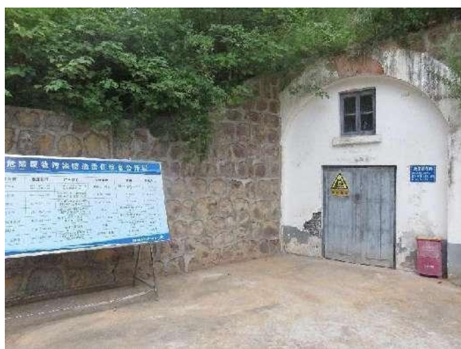
现有危废暂存间
