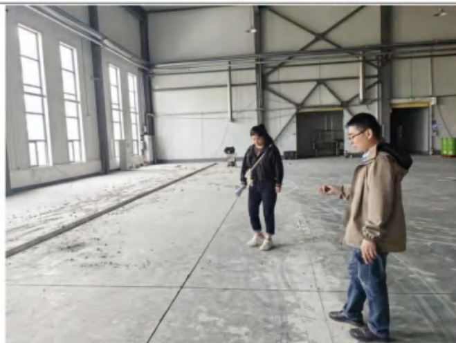
扩建项目拟建车间
