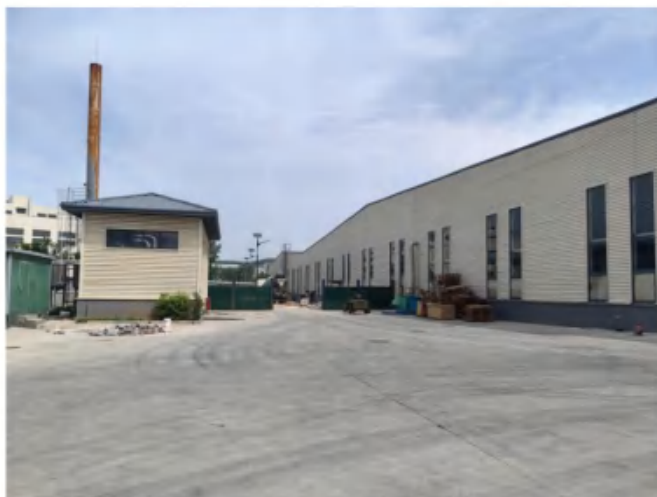
厂区现状照片
