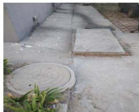
厂区化粪池出口
