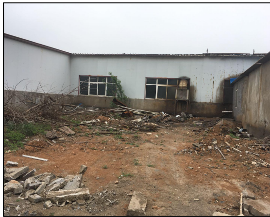
本项目循环水池拟建场所
