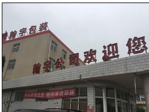
项目厂区大门
